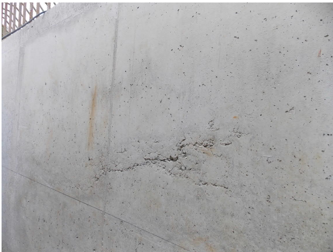
Obr.2 – Příklad špatného hutnění směsi při ukládání betonu - nepřípustné
