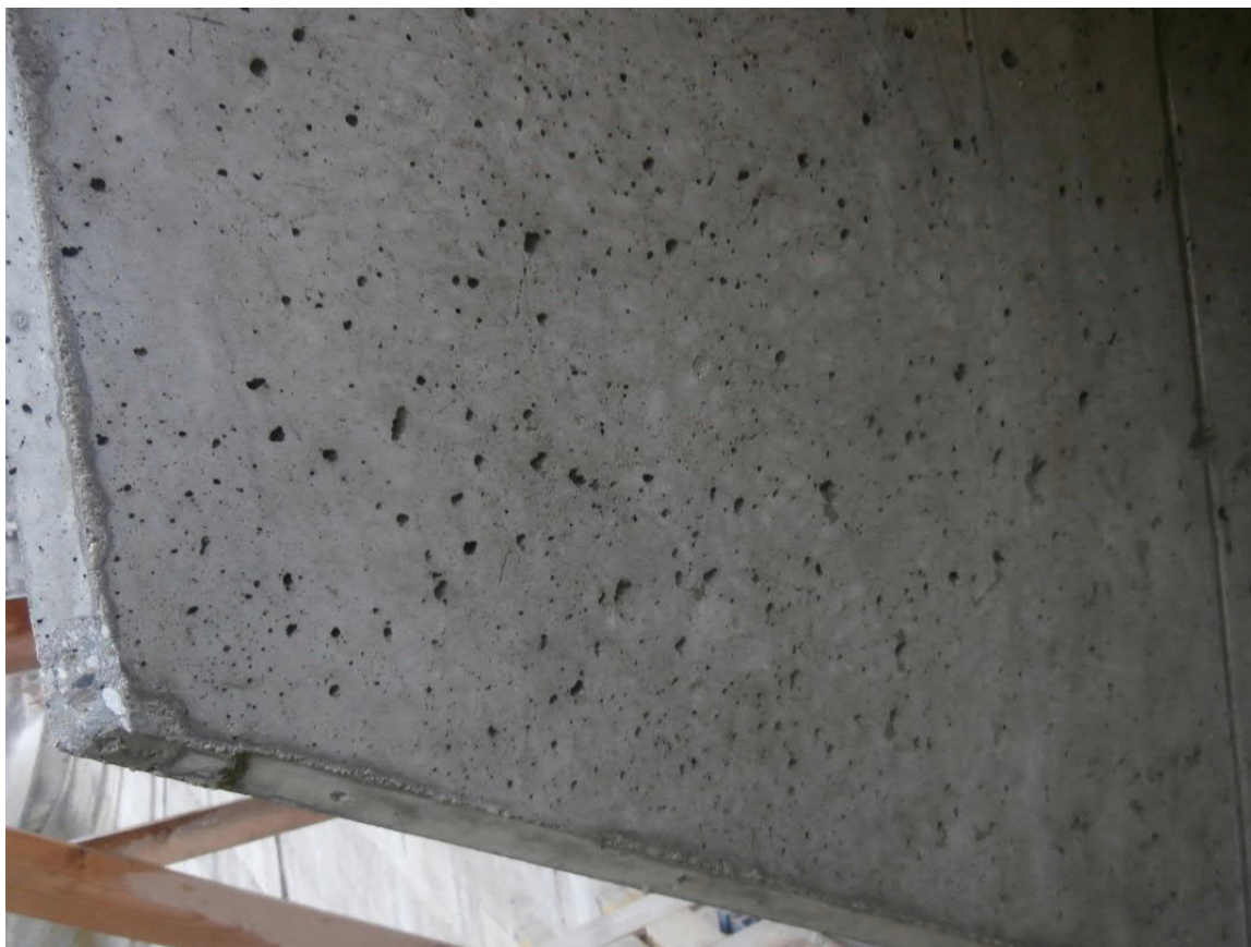
Obr.3 – Příklad nepřípustného množství a velikosti otevřených pórů pohledového betonu
